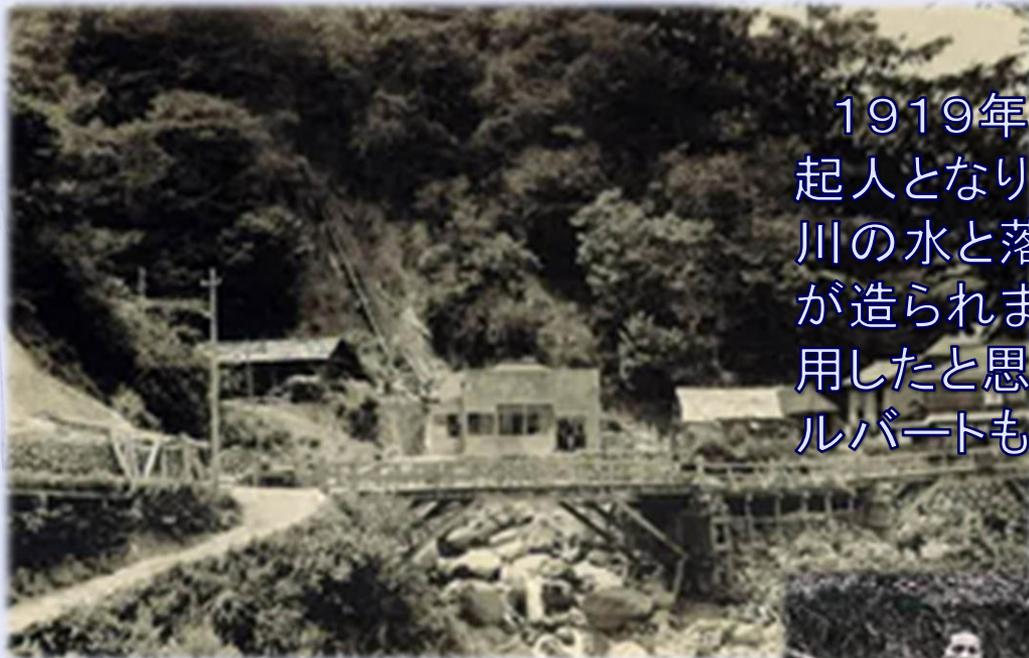
1919年(大正8年)朝倉卯八氏が代表発起人となり土湯電機株式会社を設立、東鴉川の水と落差を利用し52kwの水力発電所が造られました。当時の写真と取水路に利用したと思われるコンクリート製のボックスカルバートも見つかっています。
