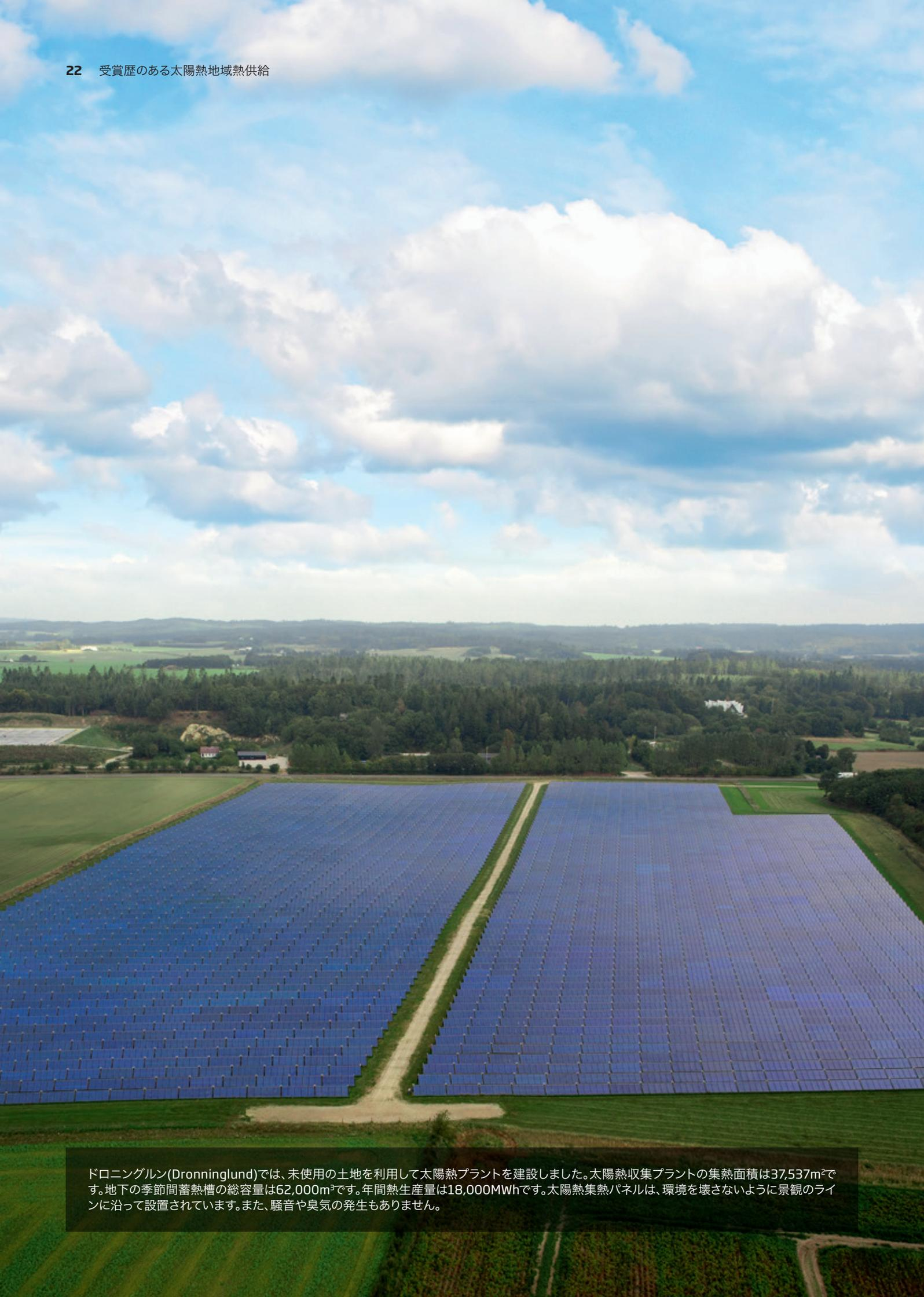
ドロニングルン(Dronninglund)では、未使用の土地を利用して太陽熱プラントを建設しました。太陽熱収集プラントの集熱面積は37537m<sup>2</sup>です。地下の季節間蓄熱槽の総容量は62,000m<sup>3</sup>です。年間熱生産量は18,000MWhです。太陽熱集熱パネルは、環境を壊さないように景観のラインに沿って設置されています。また、騒音や臭気の発生もありません。
