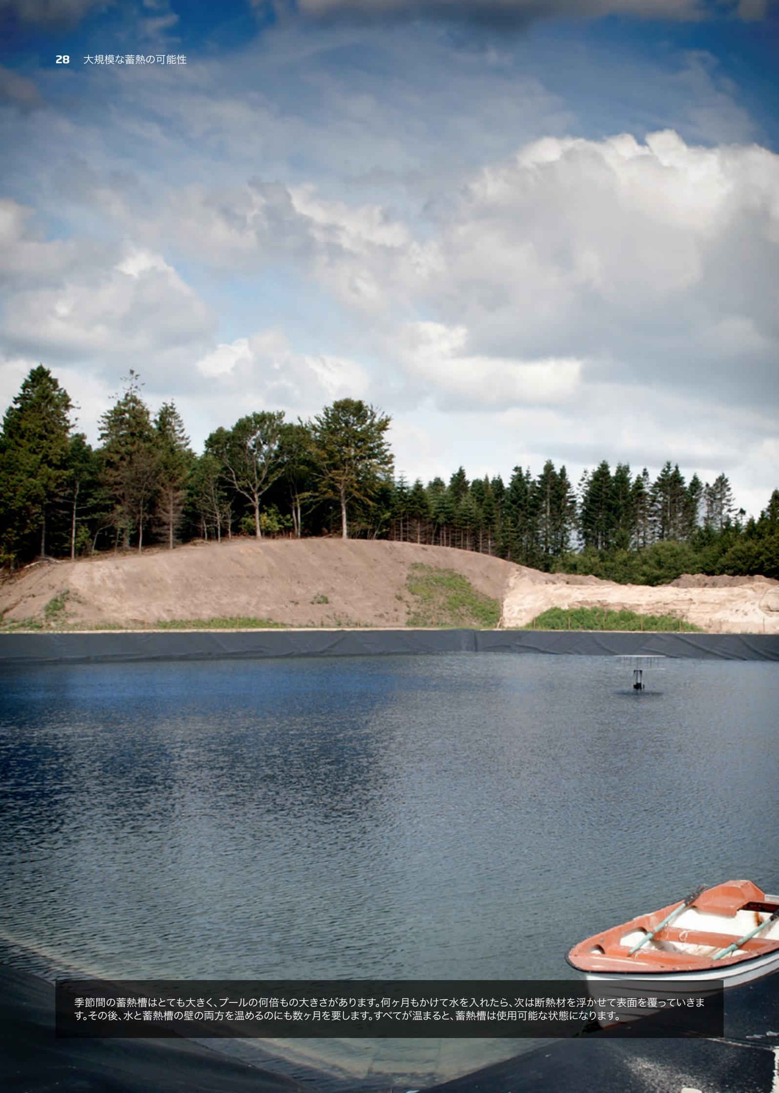
季節間の蓄熱槽はとても大きく、プールの何倍もの大きさがあります。何ヶ月もかけて水を入れたら、次は断熱材を浮かせて表面を覆っていきます。その後、水と蓄熱槽の壁の両方を温めるのにも数ヶ月を要します。すべてが温まると、蓄熱槽は使用可能な状態になります。
