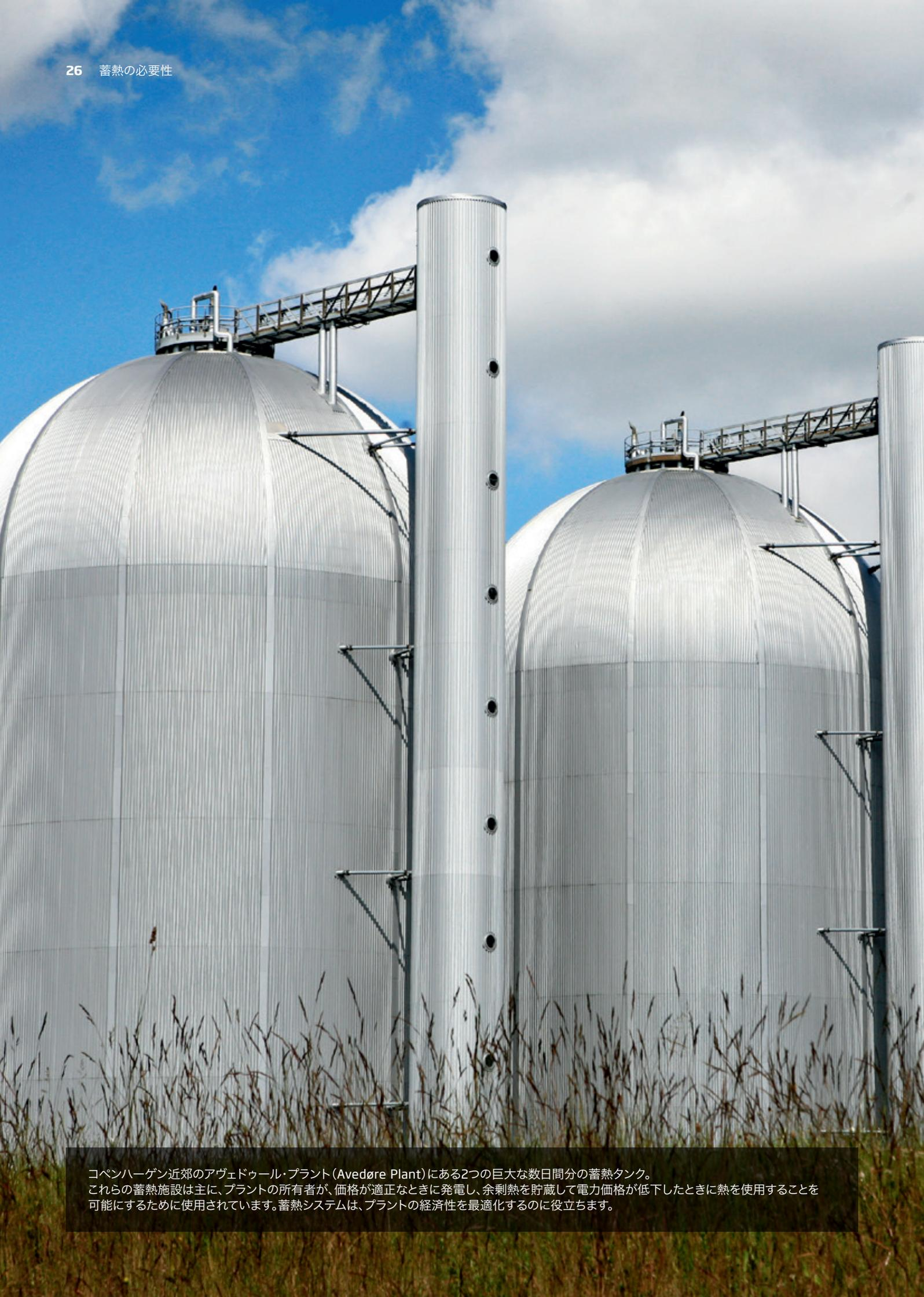
コペンハーゲン近郊のアヴェドール・プラント (Avedøre Plant) にある2つの巨大な数日間分の蓄熱タンク。これらの蓄熱施設は主に、プラントの所有者が、価格が適正なときに発電し、余剰熱を貯蔵して電力価格が低下したときに熱を使用することを可能にするために使用されています。蓄熱システムは、プラントの経済性を最適化するのに役立ちます。
