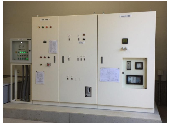
系統連系制御盤 (徳島地域エネルギー設計)
