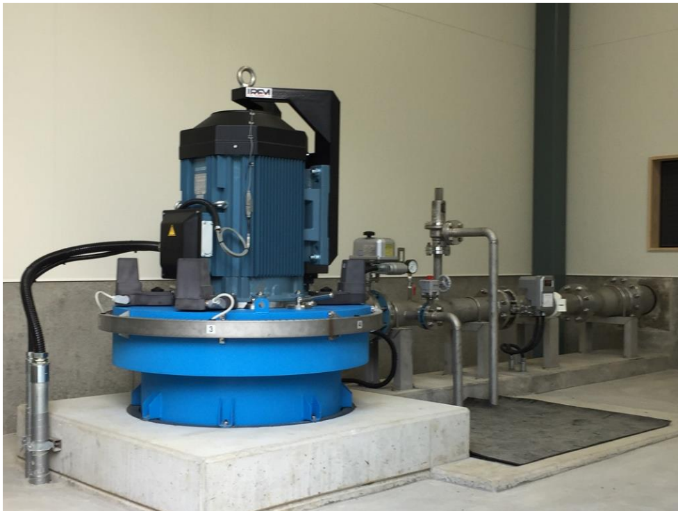
イタリアIREM社 Ecowatt 水車発電機
