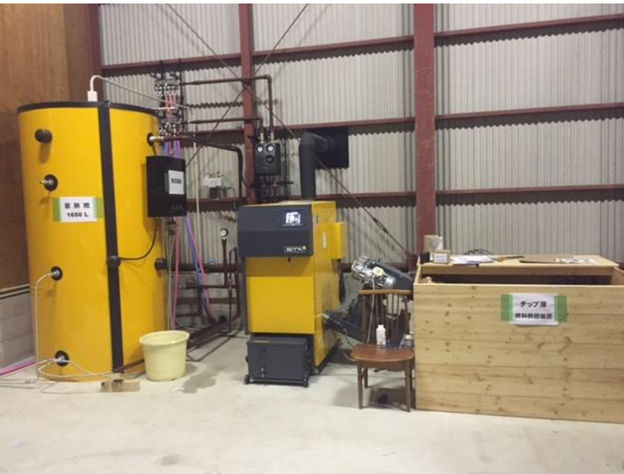
ラボ熱源施設
